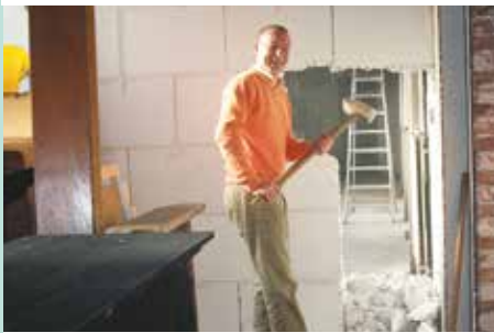
Uitbreiding naar achterliggend perceel Hoge Gouwe, 2009
